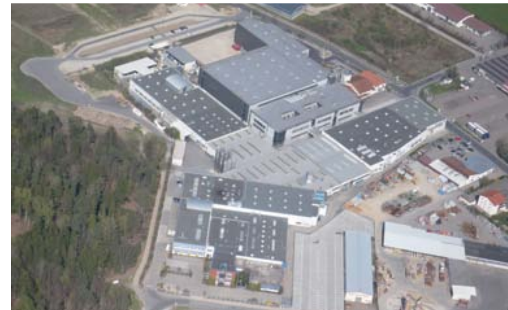
Visione aerea della sede produttiva di Cham, Germania
